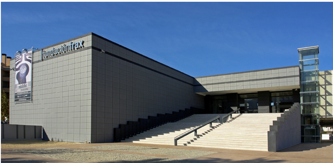
Fachada principal de la sede
